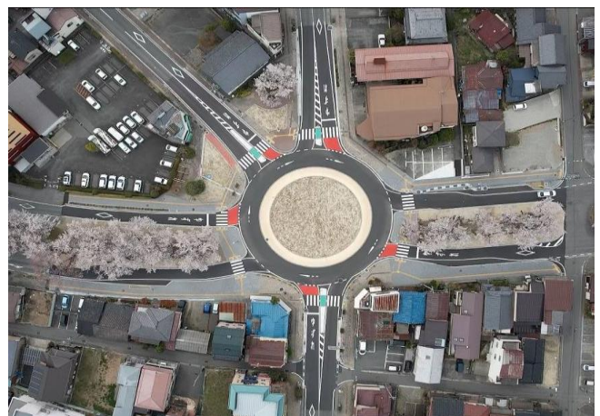
桜並木 吾妻町環状交差点 改良工事
