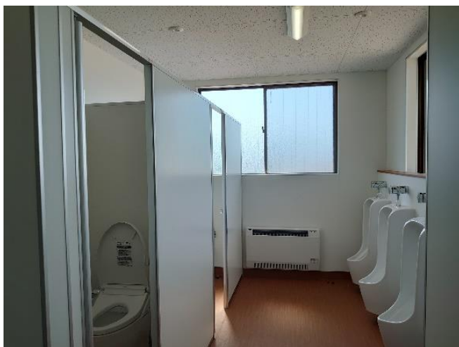
武道館トイレ改修工事（1.2階男女トイレの改修及び洋式化）
